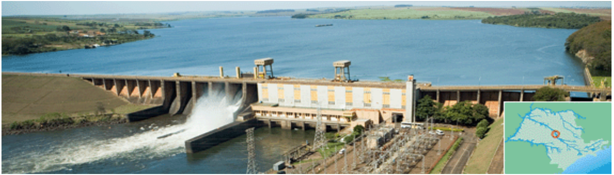
Figura 16: Hidrelétrica Álvaro de Souza Lima – Bariri (Bariri e Boracéia / SP) Foto: AES Tietê S.A.
