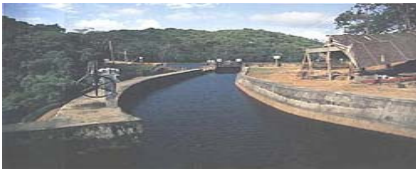
Figura 10: Hidrelétrica de Salesópolis (Salesópolis / SP) Foto: Rio Tietê sites UOL
