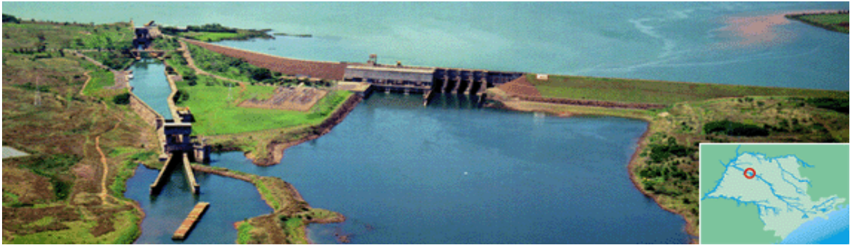
Figura 19: Hidrelétrica Rui Barbosa – Nova Avanhandava (Buritama / SP) Foto: AES Tietê S.A
