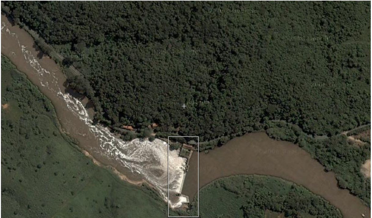
Figura 21: Vista aérea da APA do Tietê – Estrada Parque, no Município da Estância Turística de Itu, com destaque para a Hidrelétrica de São Pedro Foto: Google Earth
