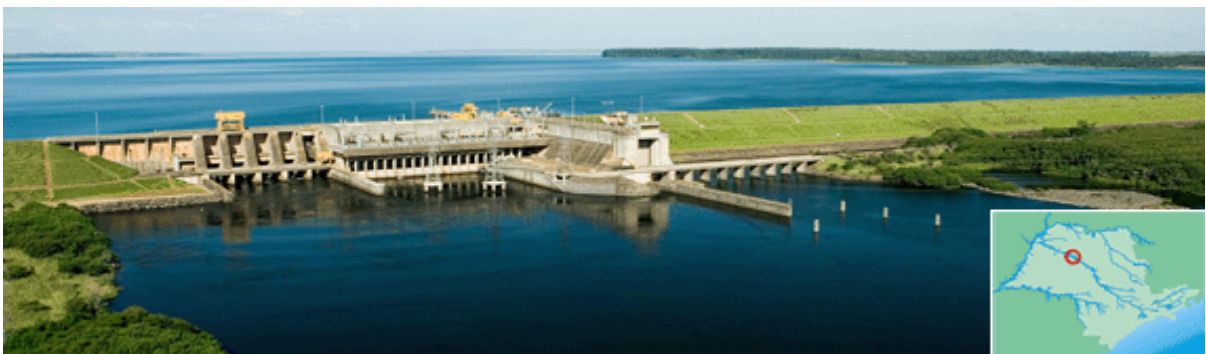
Figura 18: Hidrelétrica Mário Lopes Leão – Promissão (Ubarana / SP) Foto: AES Tietê S.A.
