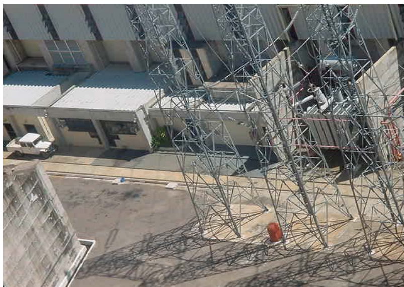
Foto 9 – sub - estação Manso – M.T.
