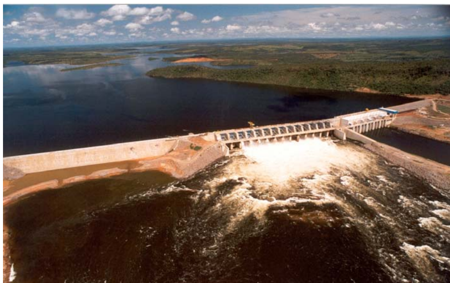
Figura 4 – Vista aérea de uma Hidrelétrica
