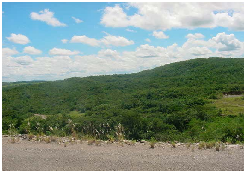
Foto 10 - Estrada de acesso para a UHE Manso – M.T.
