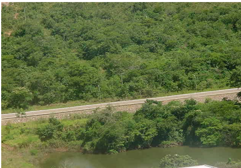
Foto 11 - Estrada de acesso para a UHE Manso – M.T.
