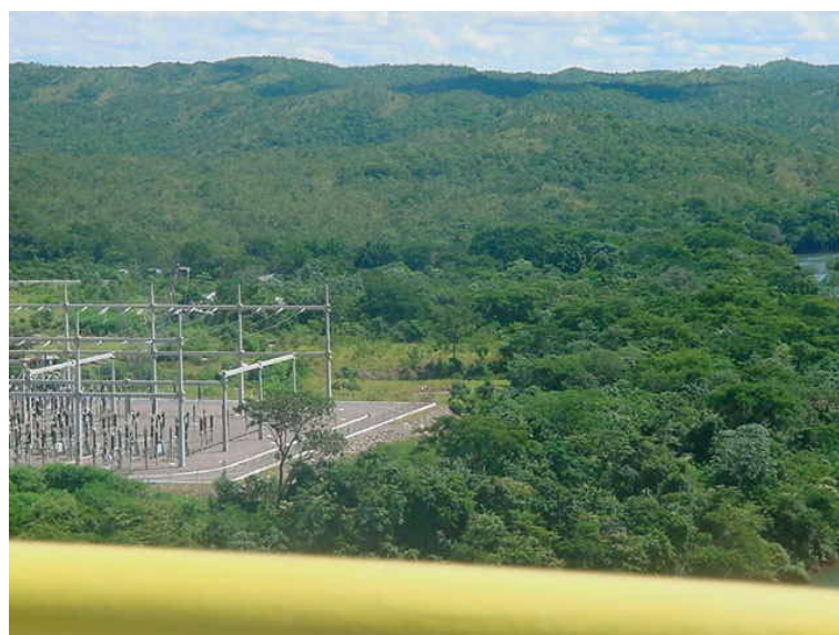
Foto 8 – Sub-estação Manso – M.T.
