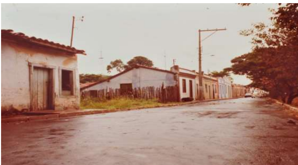
(Figura 16) Rua do Porto (Degradação do Casario). Finais de 1970
