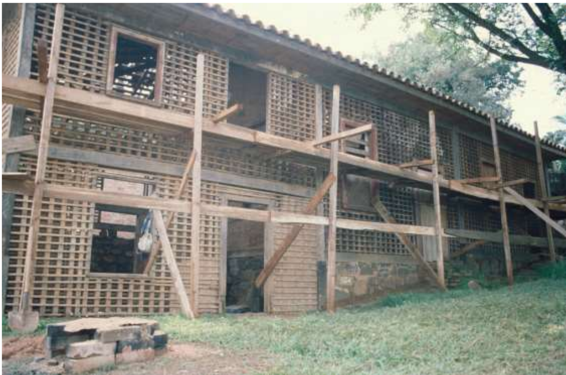
(Figura 19) Casa do Povoador (obras sistema construtivo) meados 1987
