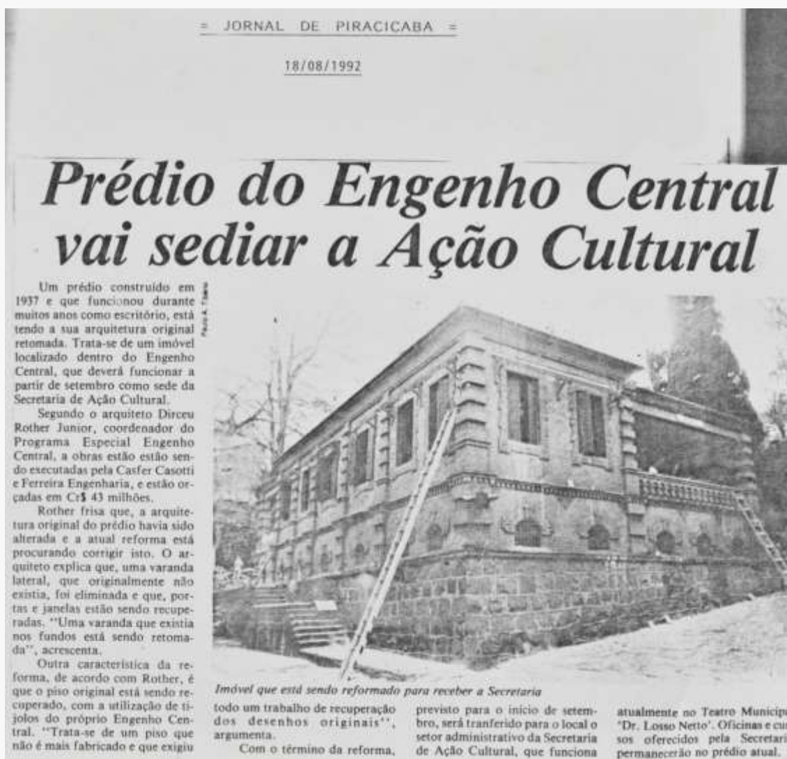
(Figura 34) Obras e Intervenções na Recuperação e Adaptações para uso Atual
