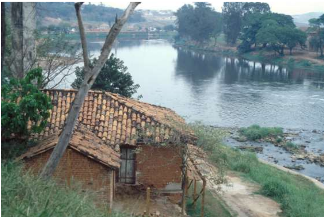
(Figura 18) Casa do Povoador início de 1987 (situação reinício das obras)
