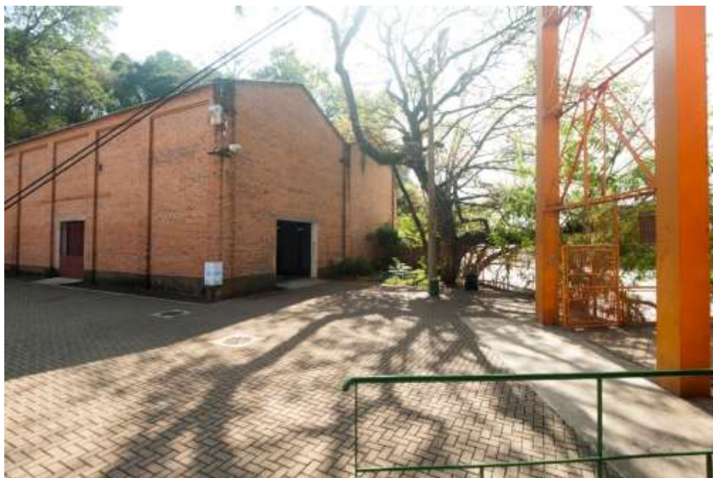
(figura 46) Edifício (14A) e Piso (Executado) Sede Administrativa e Recepção (Foto Ivan Moretti) 2016
