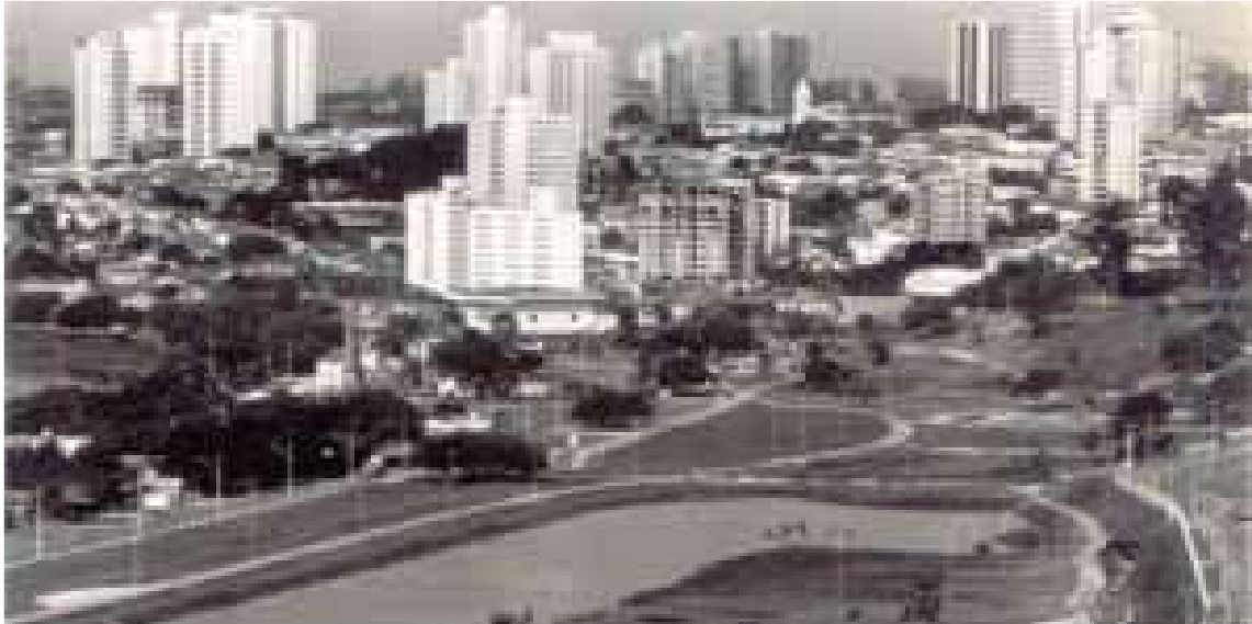
(Figura 23) Vista do Parque / Perímetros / Cidade ao fundo (em obras1988) Foto José Flávio Leão FONTE IPPLAP
