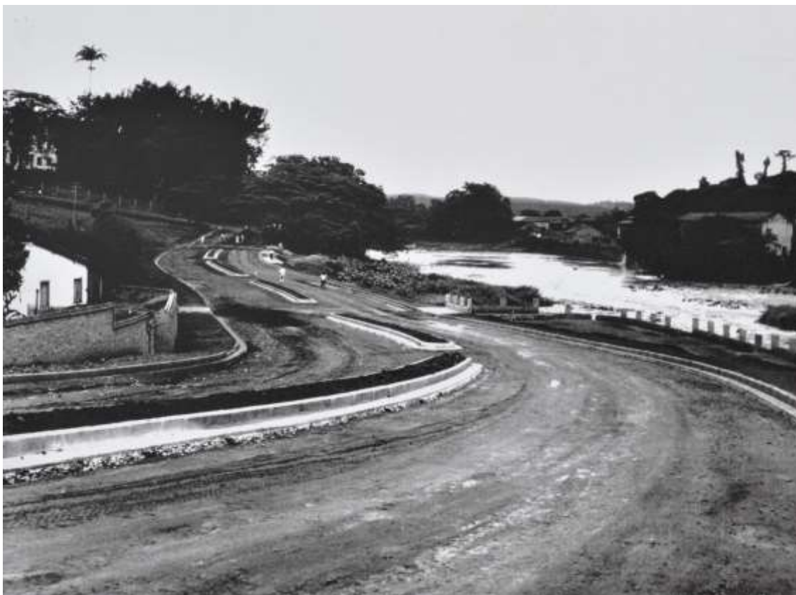
(Figura 14) Foto Avenida Beira-Rio Lado Esquerdo Fábrica Tecido Boys / Lado Direito Engenho Central (Finais de 1960)
