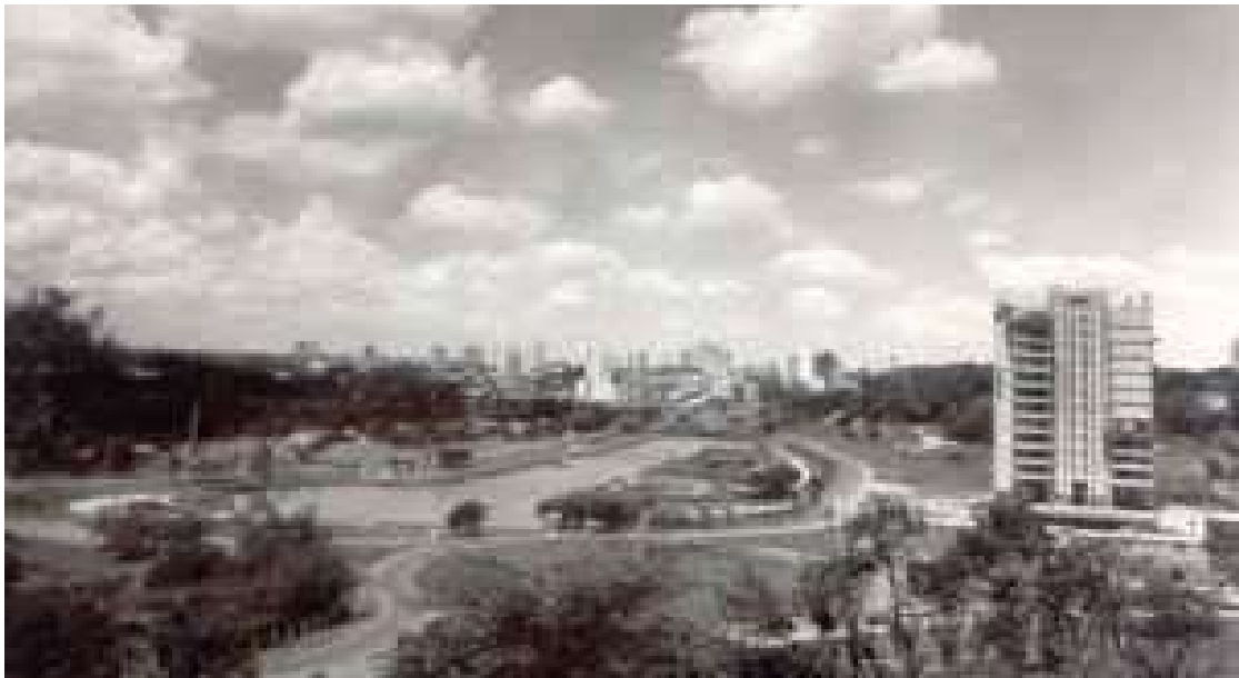
(Figura 22) Vista do Parque da Rua do Porto e Centro Cívico (em obras 1988) Foto José Flávio Leão FONTE IPPLAP
