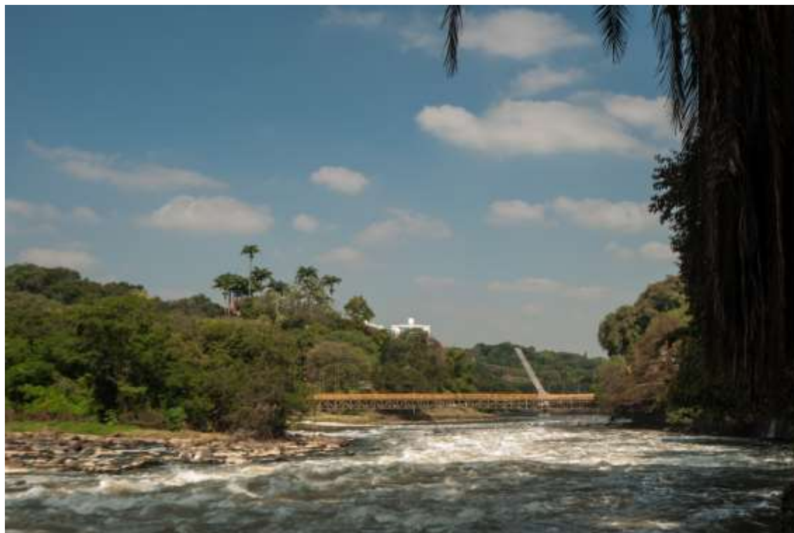
(Figura 36) Passarela Pênsil (Vista do Salto Rio Piracicaba)
