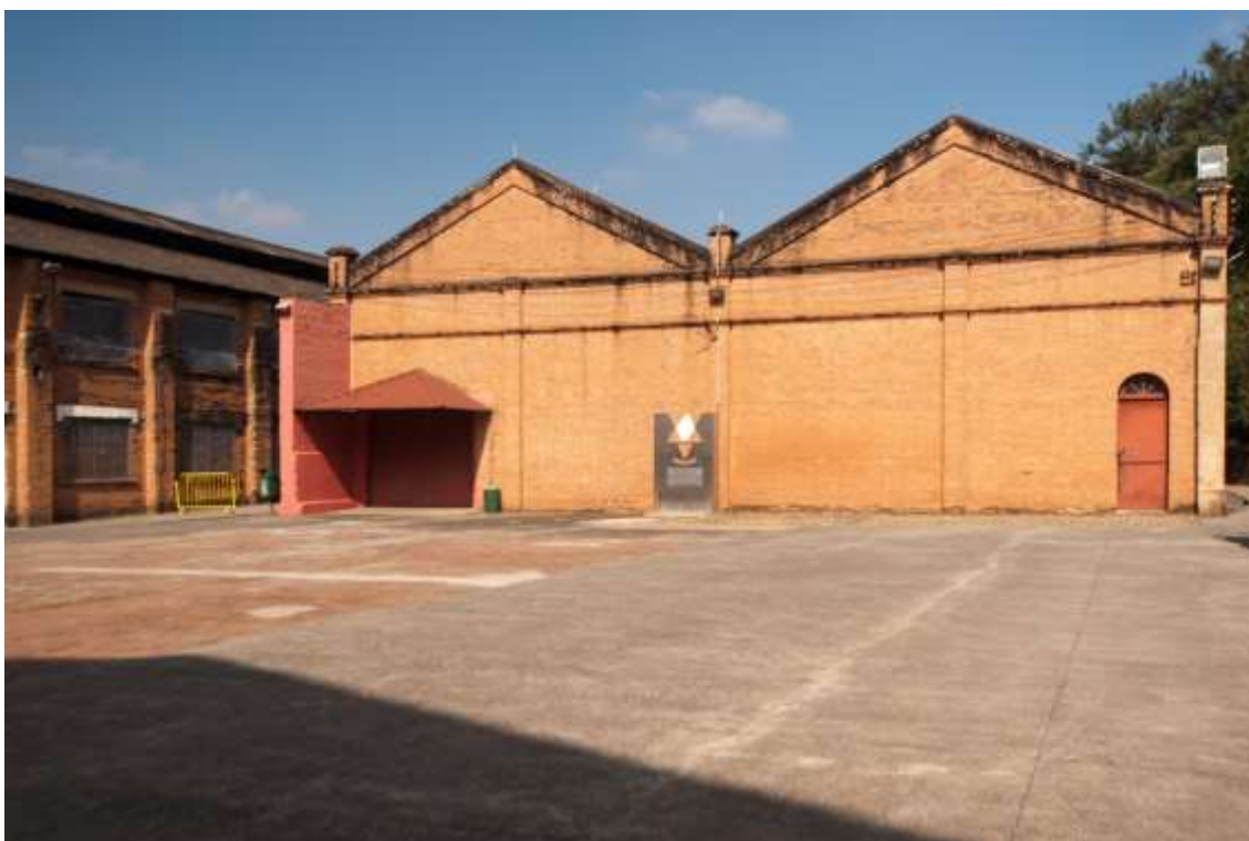
(figura 45) Fachada Edifício (14) Sede Salão Internacional do Humor (Executado) (Foto Ivan Moretti) 2016 UNIMEP
