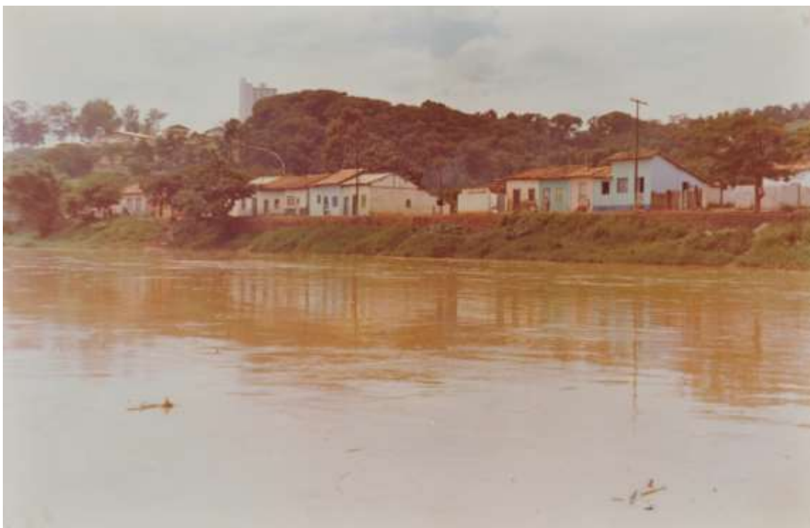
(figura 15) Rua do Porto / Rio Piracicaba (Casario de Porta e Janela). Finais de 1970
