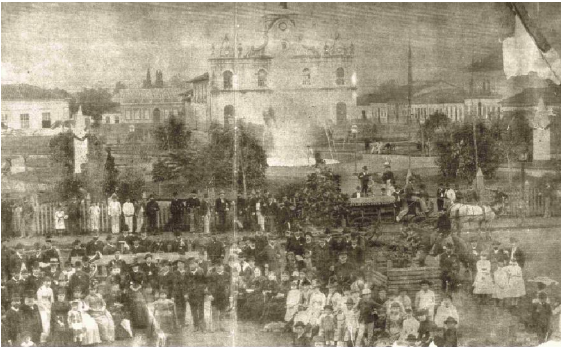
Em 1887 parte da população na praça da Igreja Matriz para distribuição da rede de água encanada. Acervo IHGP.
