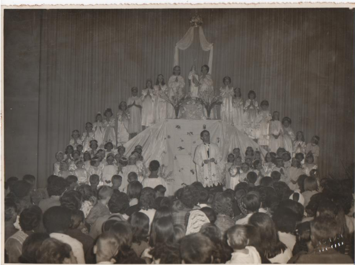
Imagem 37: Igreja São José (1968) em Corumbataí/SP
