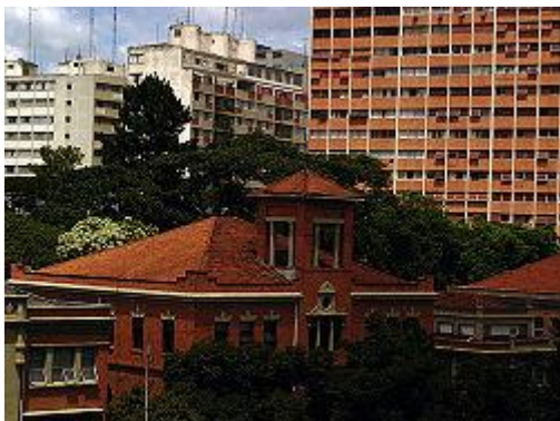
Prédio 3 – Faculdade de Direito.
