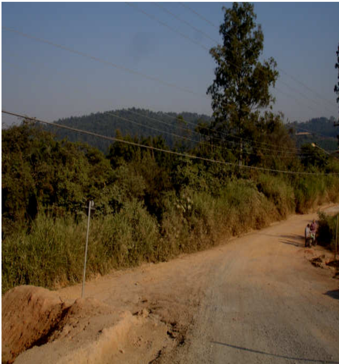
Figura 6 – Cabos telefônicos e elétricos que foram derrubados e rompidos inúmeras vezes em função do acesso provisório
