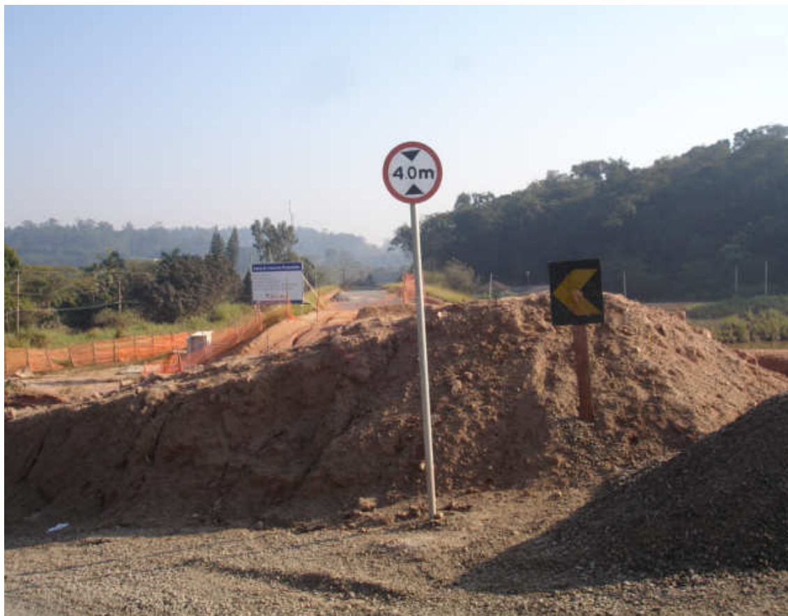
Figura 5 – Sinalização provisória para a prevenção de acidentes
