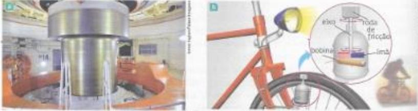
Figura 8.2. Em a temos parte da Usina Hidrelétrica de Itaipu. Eletroímãs potentes giram gerando corrente de acordo com o fenômeno de indução eletromagnética. Em b, utilizando um dinamo acoplado à roda de uma bicicleta, é possível acender uma lanterna (energia elétrica) enquanto o ciclista estiver pedalando (energia mecânica). Representação sem escala e em cores fantasia.
