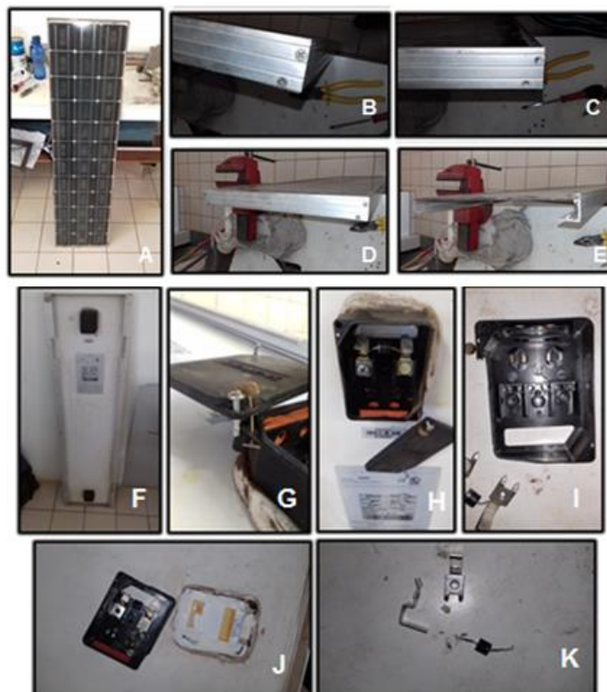
Figura 26: Etapas do processo de desmontagem do módulo FV 3.
