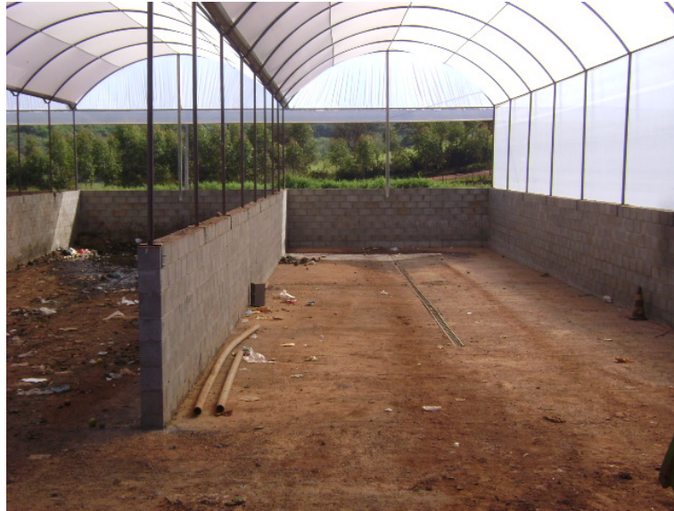
Figura 23 - Baias de compostagem detalhe na direita grelha, Kurica, Londrina, 2011
