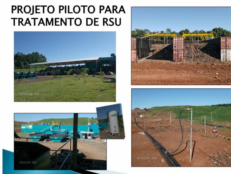
Figura 35 - Projeto-Piloto - barracão, células, injeção de oxigênio líquido, Maringá-PR, 2007
