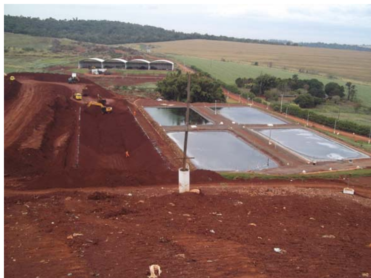
Figura 71 - Lagoas de chorume (quatro) e uma em construção a esquerda, CTR, Londrina-PR, 2012
