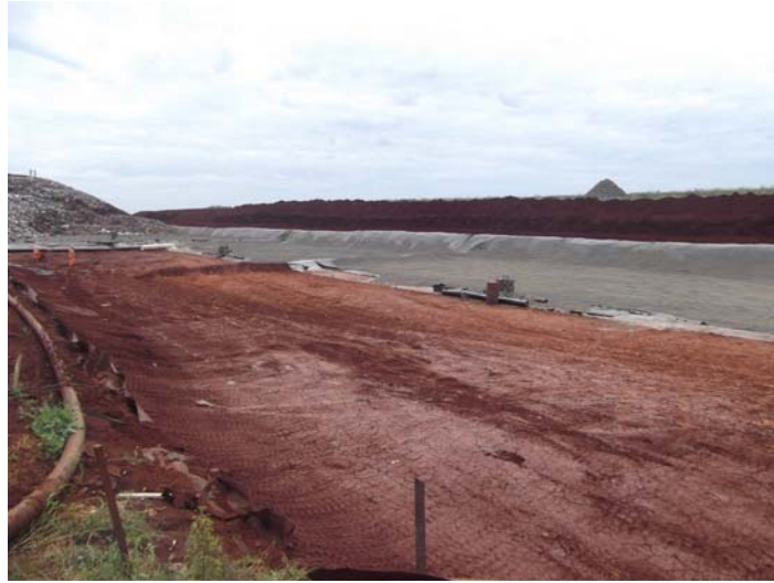
Figura 72 - Construção da terceira célula, primeira e segunda à esquerda, CTR, Londrina-PR, 2012
