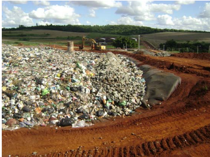
Figura 17- Disposição de Resíduos na Primeira Célula detalhe, CTR, Londrina, 2011
