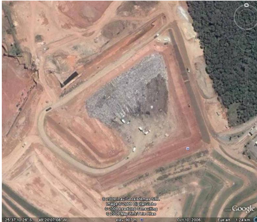
Figura 43 - Aterro da Caximba - Frente de trabalho Curitiba-PR, 2009
