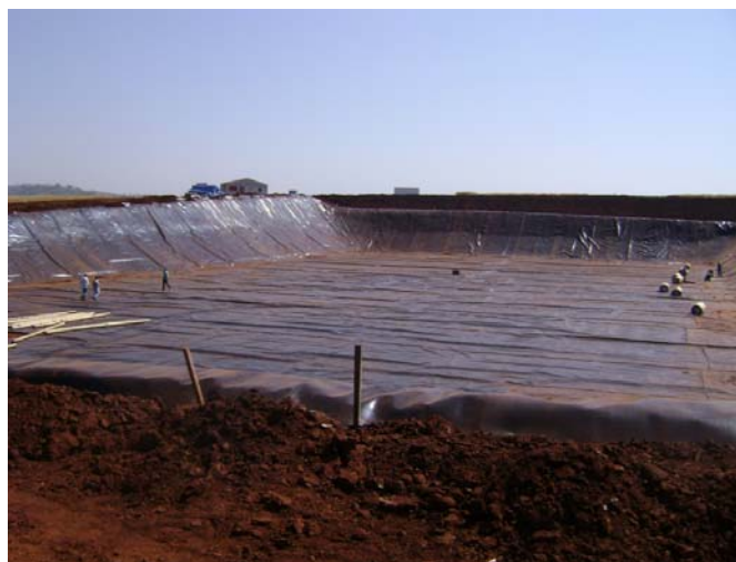
Figura 12 - Vista parcial da primeira célula da CTR - tubulação e Membrana, Londrina, 2010
