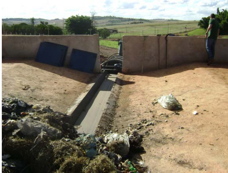
Figura 19 - Usina de triagem detalhe esteira de entrada e resíduos, CTR, Londrina, 2011
