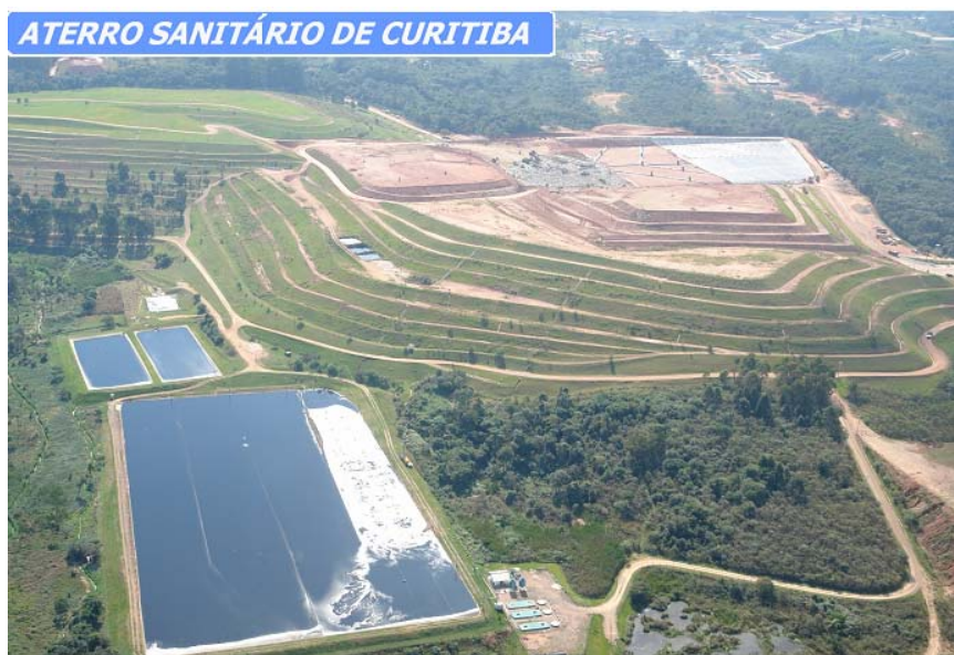
Figura 44 - Aterro da Caximba - lagoas de chorume e taludes, Curitiba-PR, 2009
