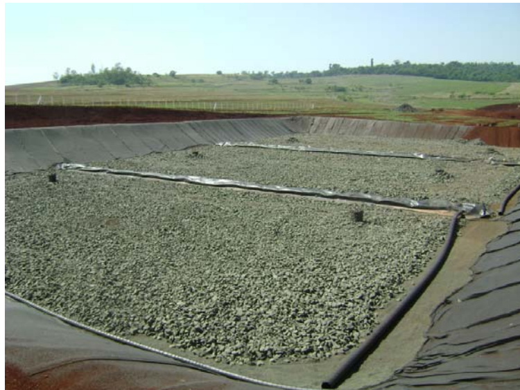
Figura 13 - Célula 1 com nova manta e pedras marroadas, CTR, Londrina, 2010
