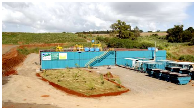
Figura 36 - Detalhe do tratamento e de área recuperada, Maringá-PR, 2007
