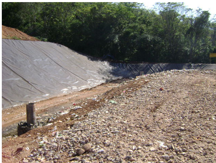
Figura 30 - Vala de aterramento de rejeitos manta e dreno, Kurica, Londrina, 2011
