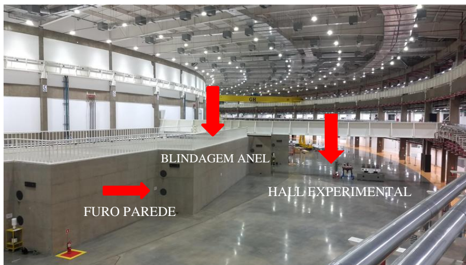
FIGURA 34 : BLINDAGEM DE RADIAÇÃO E HALL EXPERIMENTAL DO SIRIUS (AUTOR)
