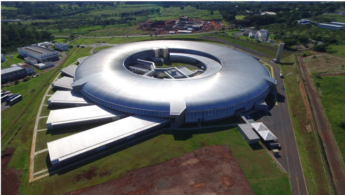
FIGURA 26 : VISTA ÁREA INSTALAÇÕES SIRIUS (REVISTA FAPESP, 2020)
