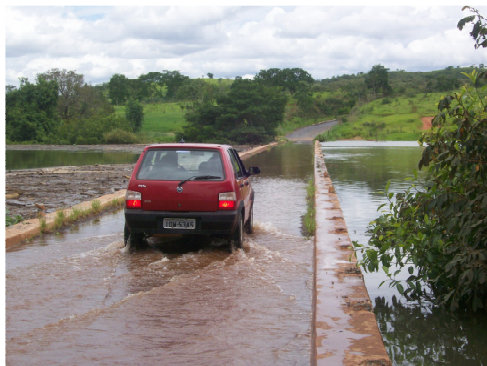
Figura 15. Antiga Ponte dos Carapinas sendo inundada (2009).
