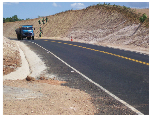
Figura 14. Novo trecho da Rodovia GO – 506 (2009).
