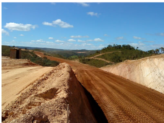
Figura 13. Trecho da Rodovia GO – 506 em construção (2009).
