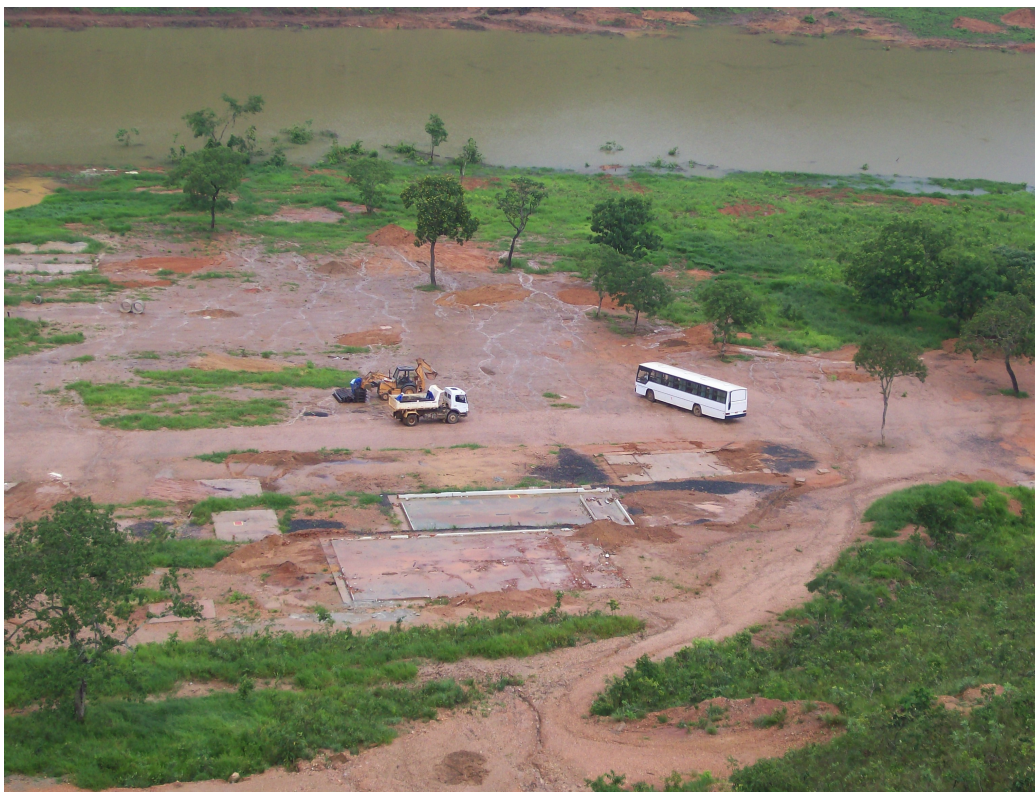
Figura 21. Canteiro de obras da UHE Serra do Facão/GO (2009).
