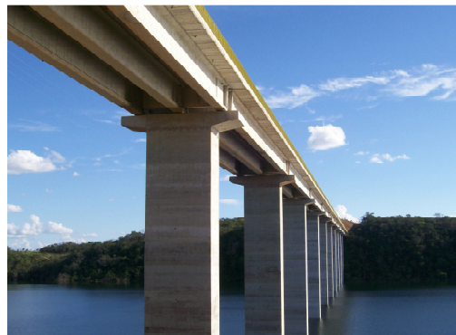
Figura 16. Nova Ponte dos Carapinas (2009).
