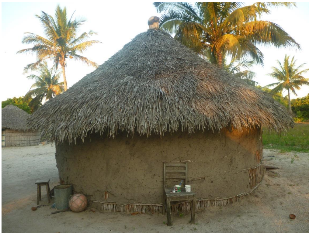
Figura 9 – Casa de terra crua – Macuanda – Zavala – Provincia de Inhambane - Moçambique
