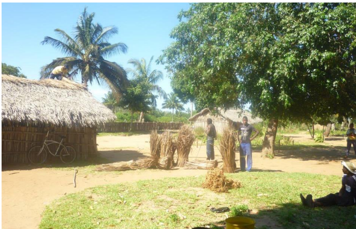
Figura 44 – Manutenção da cobertura das salas de aulas da Escola Primária Completa de Macuanda realizado pelos pais dos alunos
