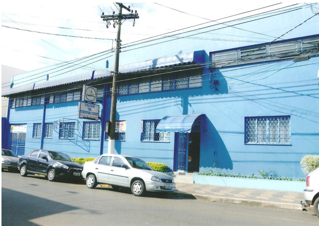
ANEXO O – Fachada do Prédio Atual em 13/08/2013.
