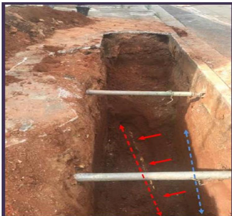
FIGURA 11 - VISTA DA VALA INDICANDO POSICIONAMENTO DA TUBULAÇÃO DE GÁS.
