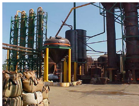
Figura 30 - Reator de enriquecimento Fonte: Nheel Química, 2004
