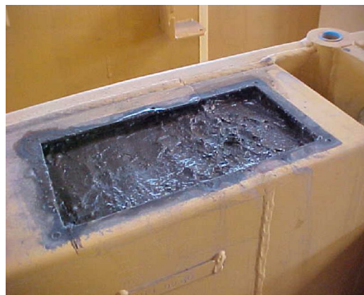
Figura 35 - Vista dos contrapesos Fonte: Ambiental Paulista, 2004
