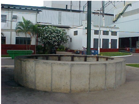
Figura 25 - Poço de carepa Fonte: SID SI, 2004
