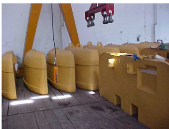
Figura 34 - Colocação da massa no contrapeso Fonte: Ambiental Paulista, 2004
