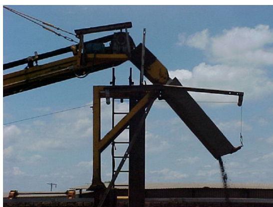
Figura 42 - Saída da terra da “Shredder” processada Fonte: Bugue Reciclagem
