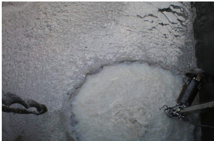
Figura 9: Foto do Efluente Bruto na Entrada da Equalização.
