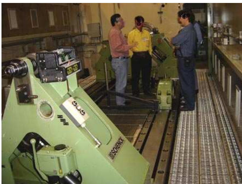
Figura 22. Parte interna de um túnel de vácuo (NOBREGA, 2005)
