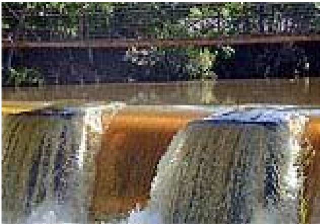
Figura 24 B - Antiga usina de Brotas, localizada próximo ao centro da cidade, é formada no leito do rio Jacaré Pepira. FONTE: www.brotas.com.br/brotas/atrativos- 8/4/2002 21:19:30
