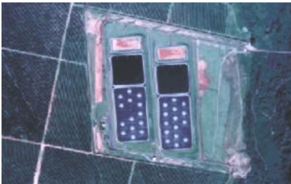
FIGURA 28 - Estação de Tratamento de Esgotos de Araraquara 59 , localizada na Rodovia SP 255 às margens do Ribeirão das Cruzes, possui dois módulos com capacidade total de tratamento de 800 litros de esgotos por segundo. Cada módulo é composto de Lagoa Aerada, Lagoa de Sedimentação e Lagoa de Lodo.
