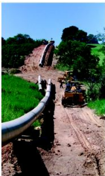
FIGURA 26 – Trecho do Gasbol, sendo montado.
