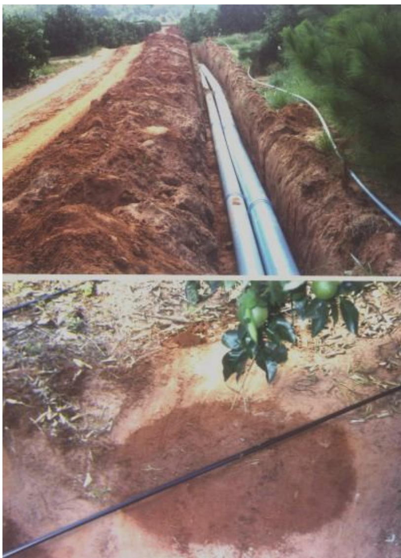
FIGURA 21 - Sistema de irrigação por gotejamento em uma fazenda de Laranja na região de Araraquara. A captação é de água superficial (rio).
